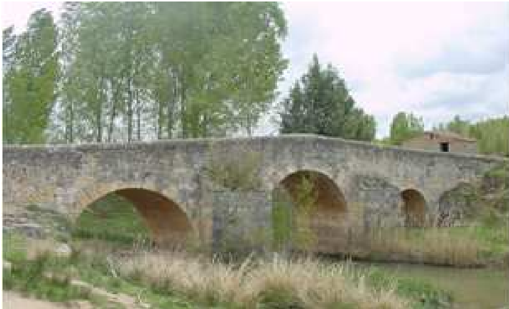
Puente de La Tejera (Quemada), en calzada romana sobre el río Arandilla
